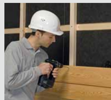
Die Fassadenbekleidung wird auf einer weiteren Konterlattung befestigt.
