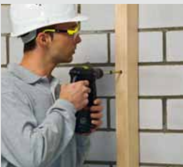
Ein Unterkonstruktion aus Holz wird an die tragende Wand montiert.
