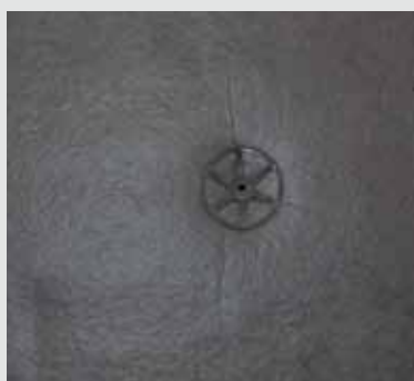
Die Platten werden mit Dämmstoffhaltern fixiert.
