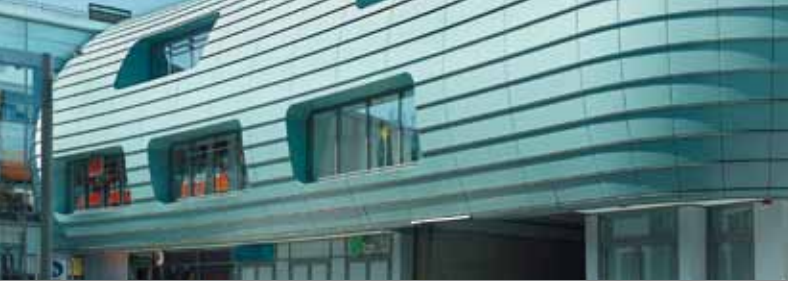
Vorgehängte hinterlüftete Fassade
