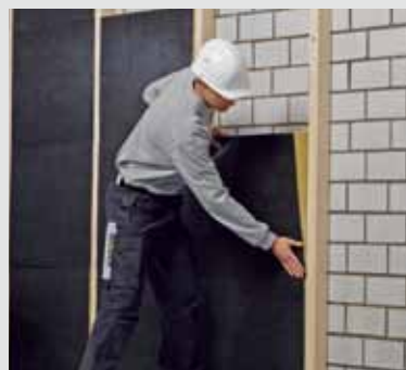
ISOVER Fassaden-Dämmplatten werden einfach zwischen die Holzkonstruktion geklemmt und mit Dübeln befestigt.
