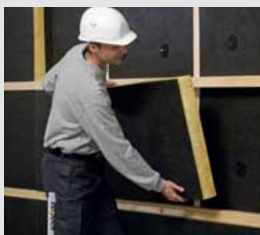
... eine zweite, versetzte Lage Dämmplatten geklemmt.
